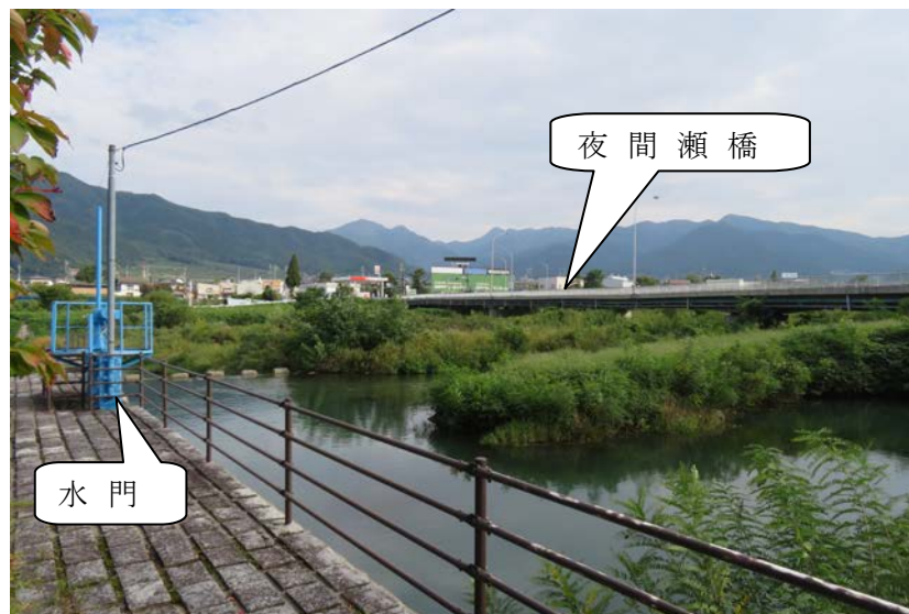
（夜間瀬橋と堤外水門）
